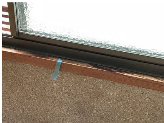
窓枠 雨染み
