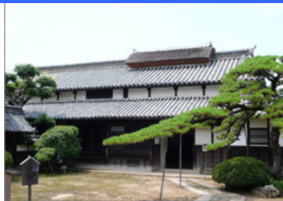
庄屋屋敷 瓦葺、真壁
