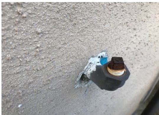
ガス管 隙間
