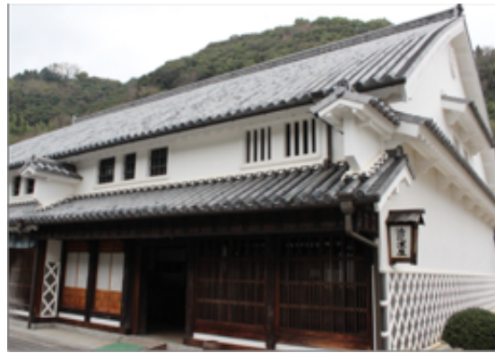
町家 厨子2階、瓦葺、虫籠窓、うだつ壁
