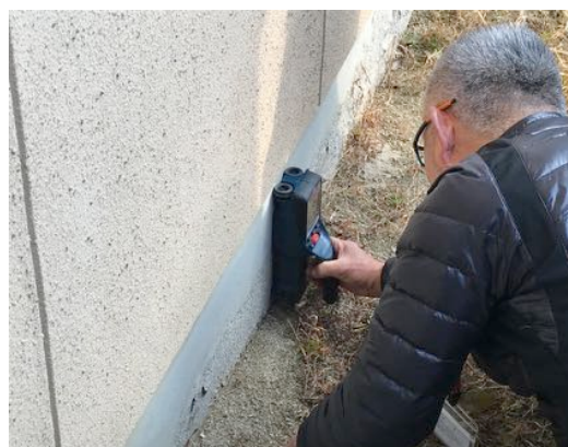
基礎の 配筋検査
